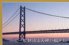
明石海峡大橋
