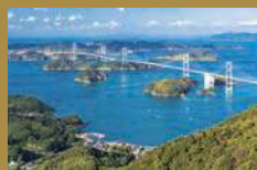
来島海峡大橋
